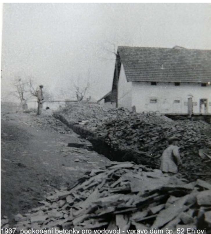
1937 podkopání betonky pro vodovod - vpravo dům čp. 52 Ehlovi
