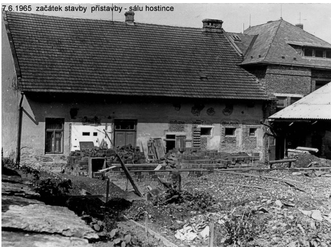
1.11.1964 - přibýly i zdi patra nové přístavby. Na lešení jsou plátěné reklamy na drubeží hody
